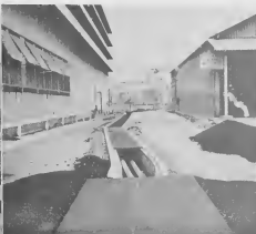
TUR DOS tanki y linja a worde trahi y instalá pa Ethyl door di Curacaose Dokmaatschappij y sub-contraatistanan. Manke e compuesto di chumbo ta casi dos vez mas piés cu awa, linja regular di tres diun ta haba e compuesto pa tanki.
